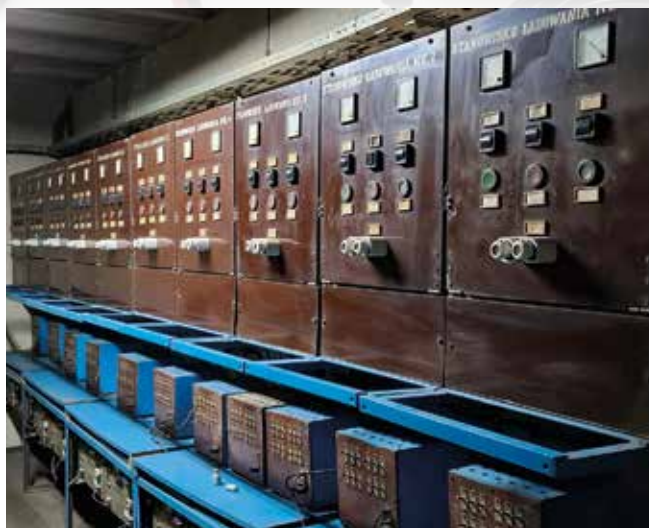
Widok warsztatu przed remontem
