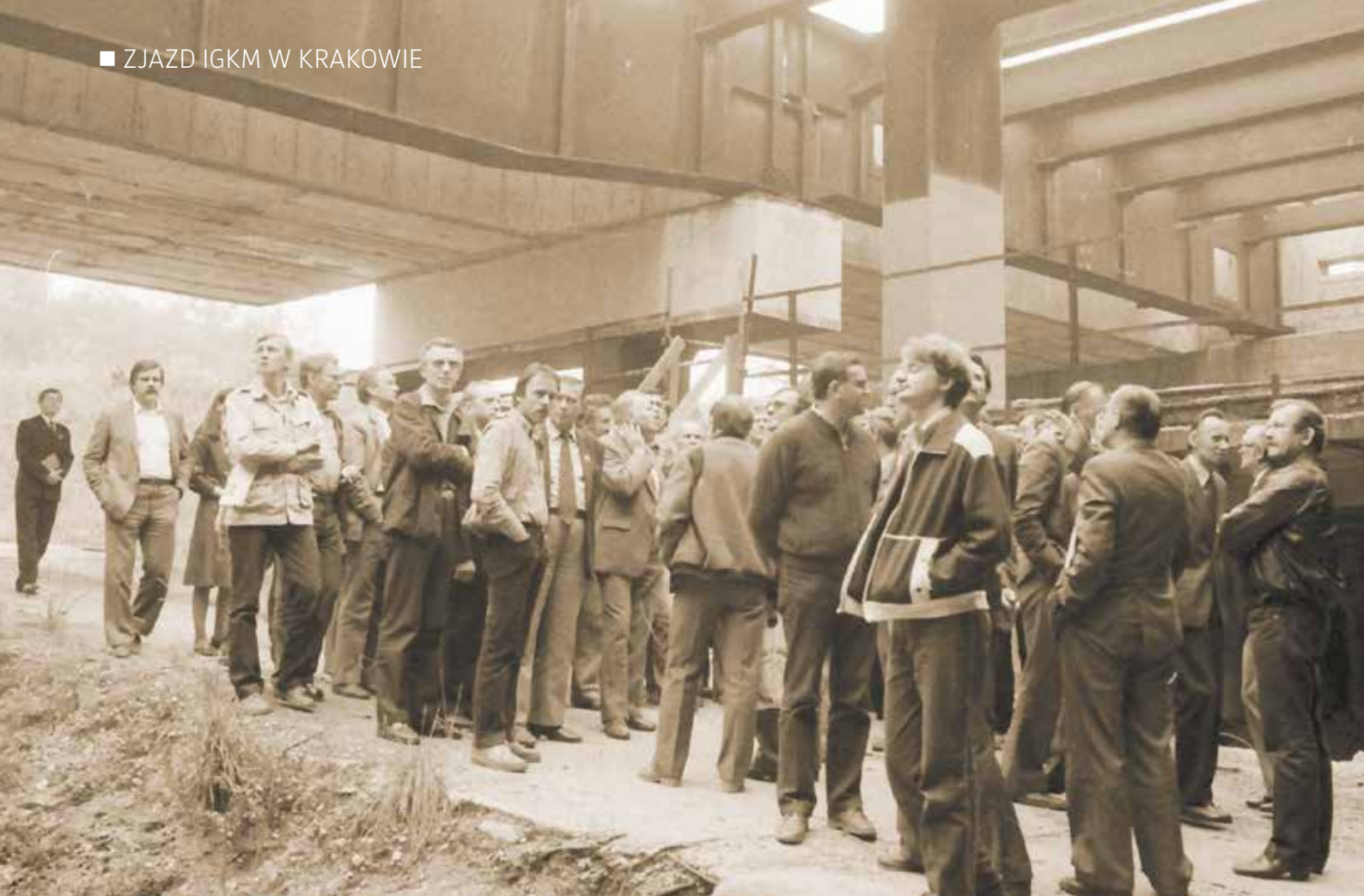
XX Zjazd Komunikacji Miejskiej – wizyta uczestników Zjazdu na budowie dworca kolejowego w Krakowie, IX 1984 r.
