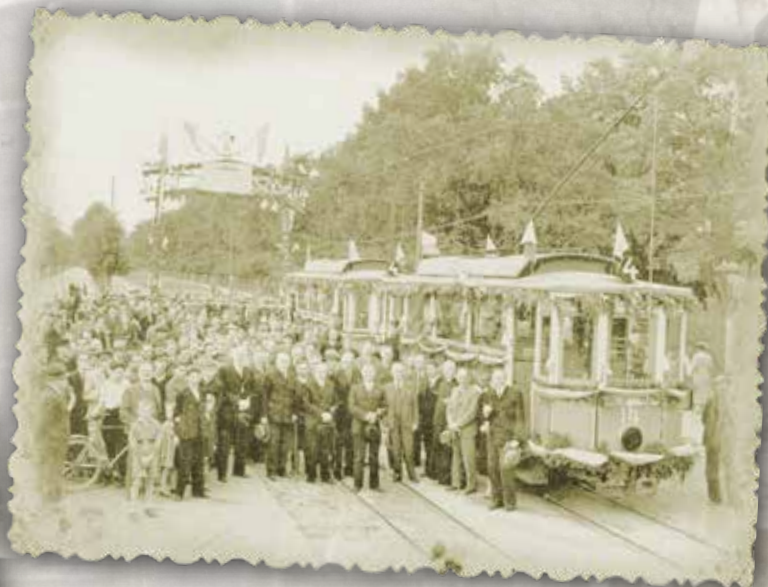
Uruchomienie linii tramwaju elektrycznego
