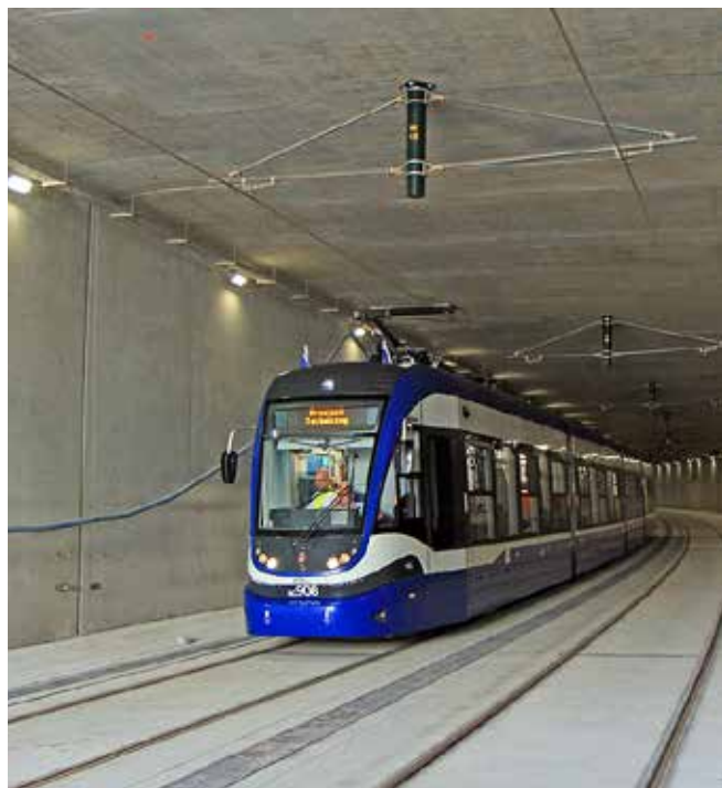
Przejazd tramwaju przez tunel Trasy Łagiewnickiej. Fot. Michał Wojtaszek
