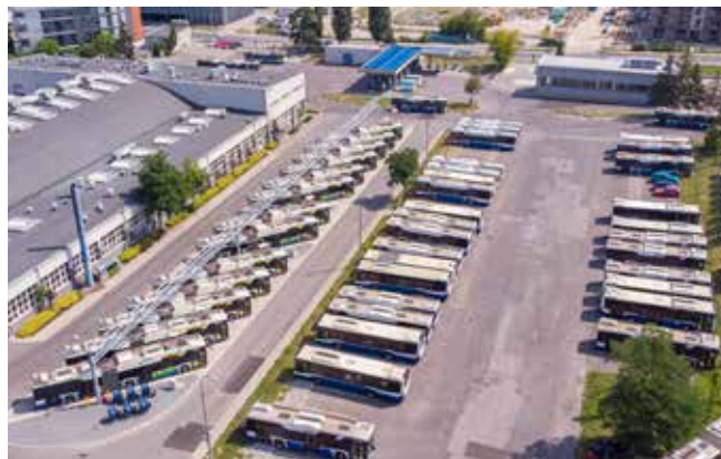
Na terenie Stacji Obsługi Autobusów Wola Duchacka powstanie kolejne miejsce do ładowania autobusów zasilanych energią elektryczną
