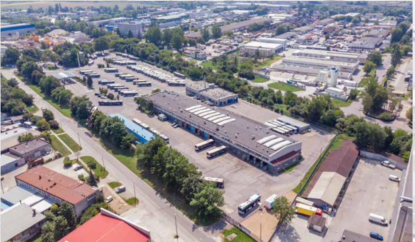
Obecny widok Stacji Obsługi Autobusów Płaszów
