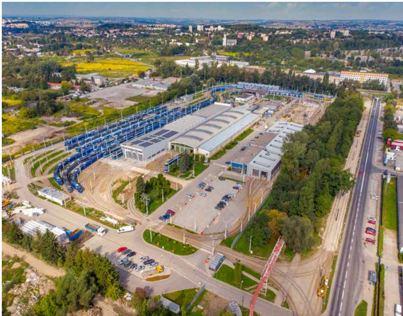
Panele fotowoltaiczne na nowej hali w Stacji Obsługi Tramwajów Nowa Huta
