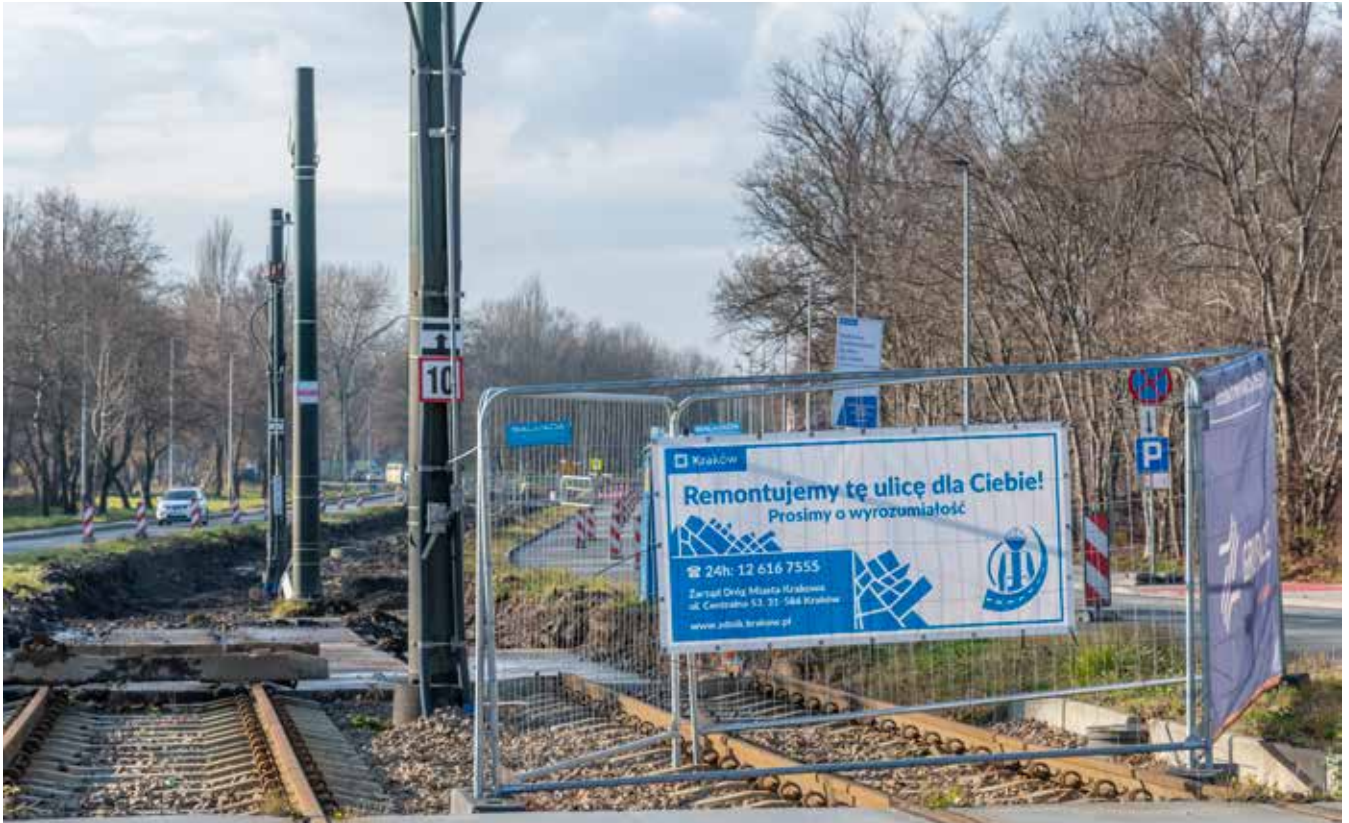
Trawa remont torowiska na ul. Ptaszyckiego
