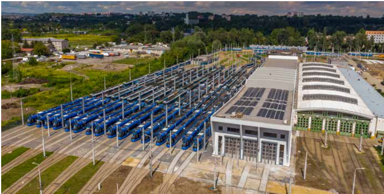
Wraz z dostawami nowych wagonów modernizowana jest Stacja Obsługi Tramwajów w Nowej Hucie. Stacjonuje tam 35 Lajkoników.
