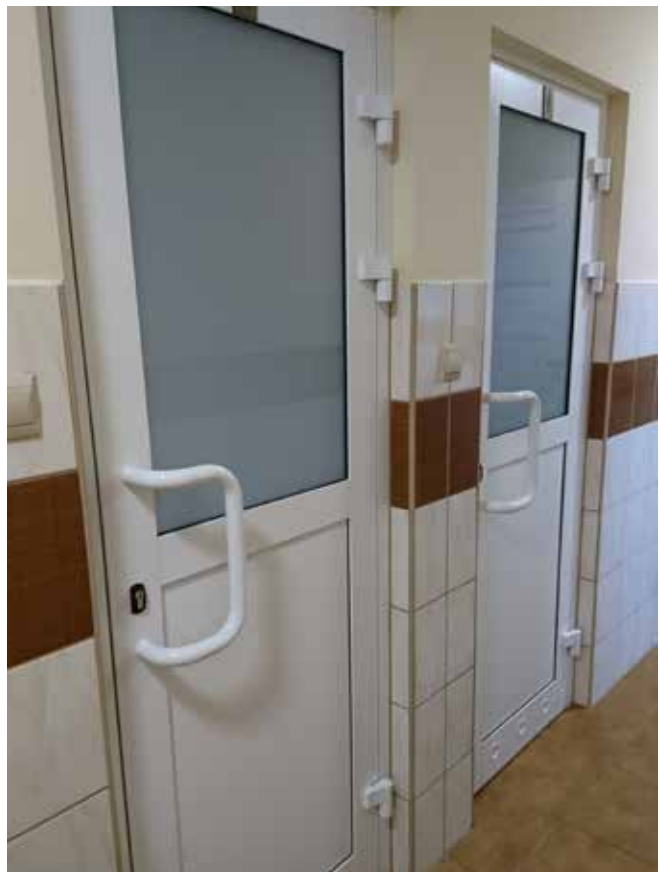
Punkt Socjalny na pętli Mistrzejowice po remoncie
