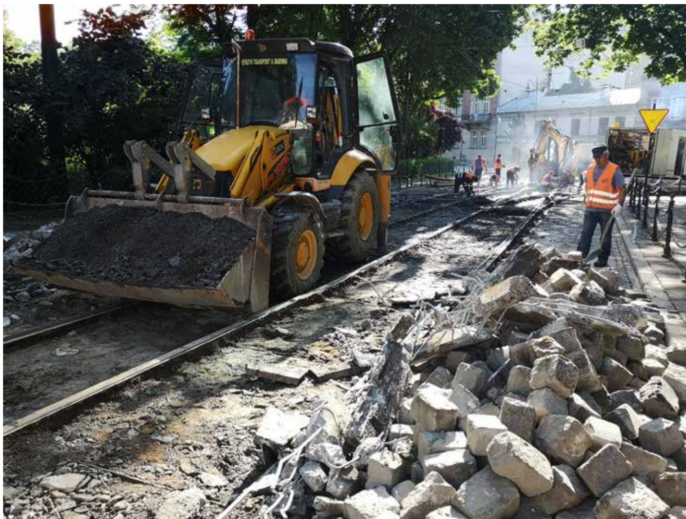
Prace serwisowe na skrzyżowaniu ul. Dominikańskiej i św. Gertrudy
