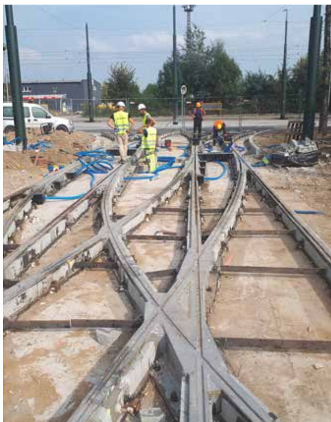
Prace przy II bramie w Stacji Obsługi Tramwajów Nowa Huta
