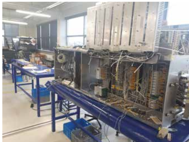
Montaż szaf sterujących
