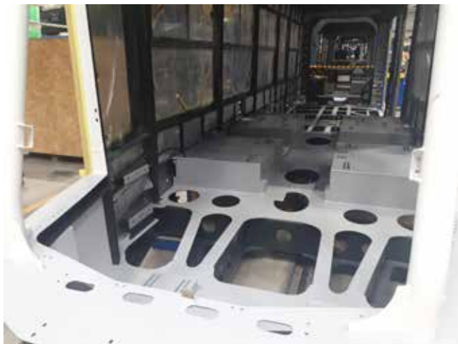
Konstrukcje stalowe są przygotowywane w Środzie Wielkopolskiej
