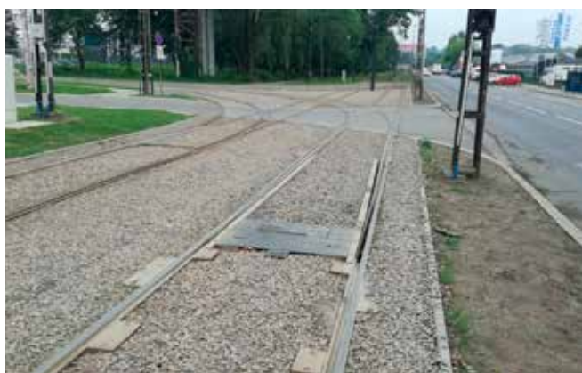
Przebudowany układ torowy w bramie numer 1
