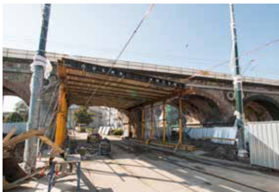
i przez ul. Grzegorzecką pod przebudowywanym wiaduktem kolejowym
