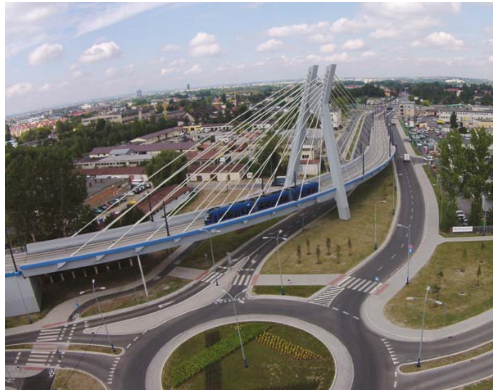
Nowa estakada tramwajowa łącząca ul. Wielicką z Lipską
