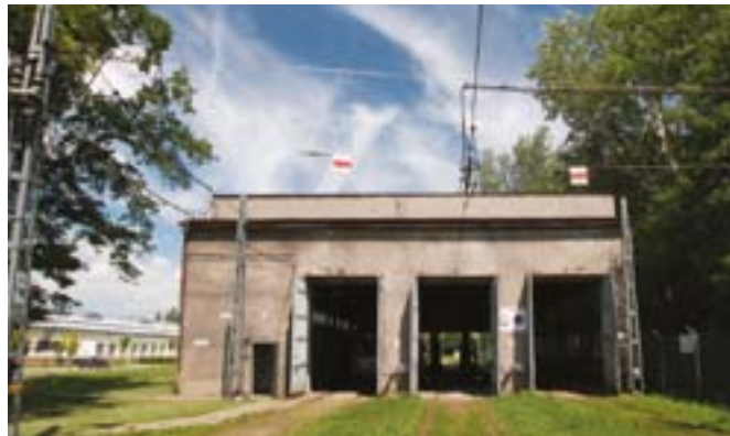
Budynek myjni w Nowej Hucie zostanie zburzony
