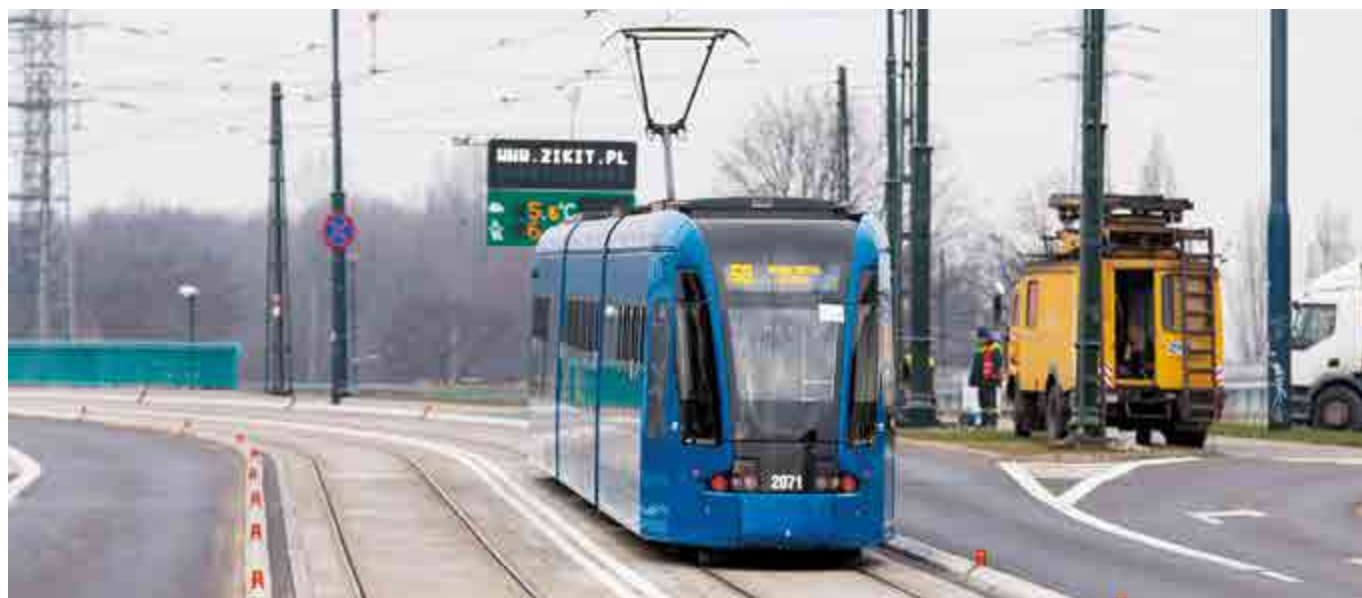
Zmodernizowane torowisko w ul. Na Zjeździe
