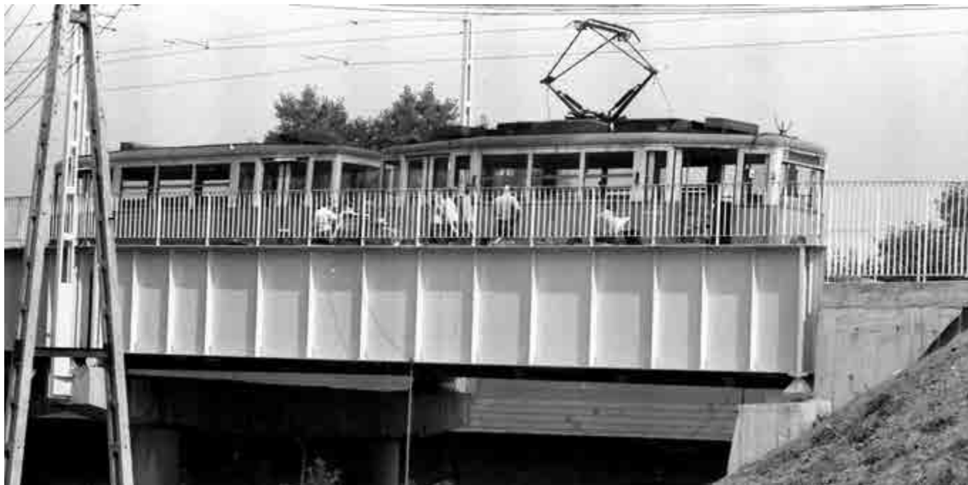
Próbne obciążenie wiaduktu – ul. Prądnicka, sierpień 1984
