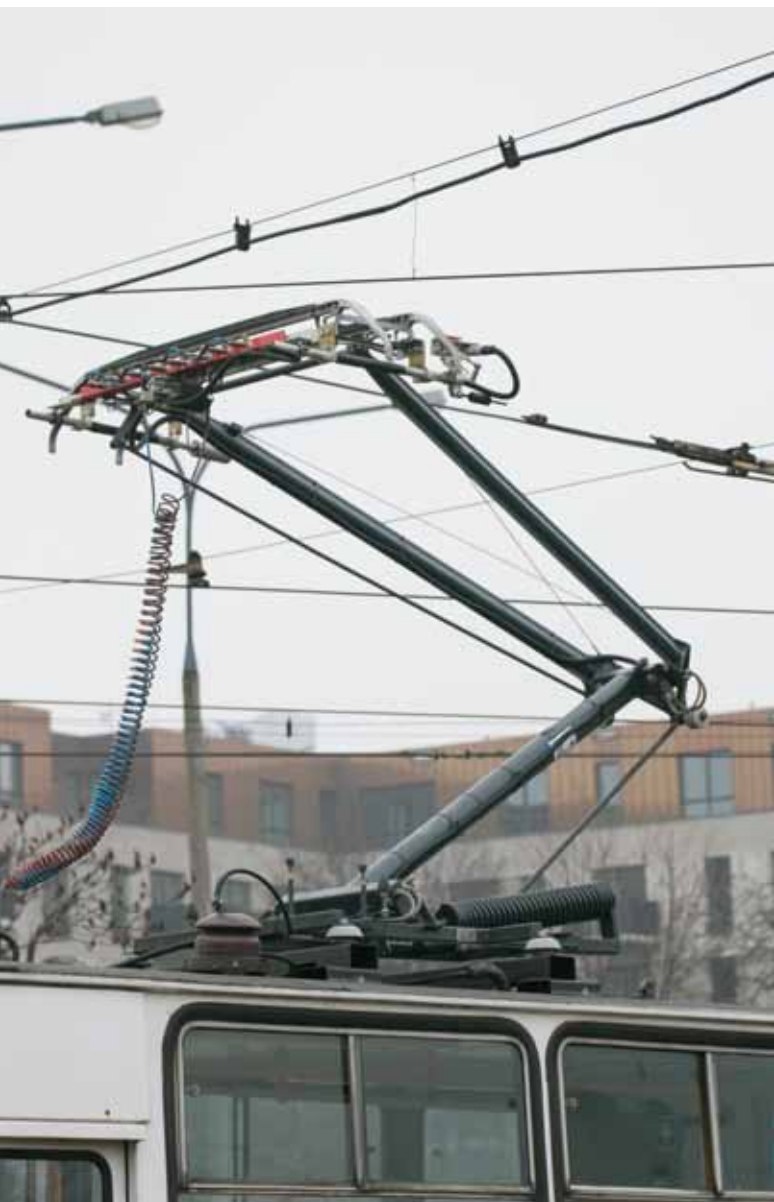
Urządzenie do odladzania sieci jest zamontowane na pantografie...
