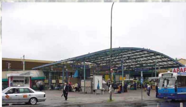
Dworzec przed modernizacją
