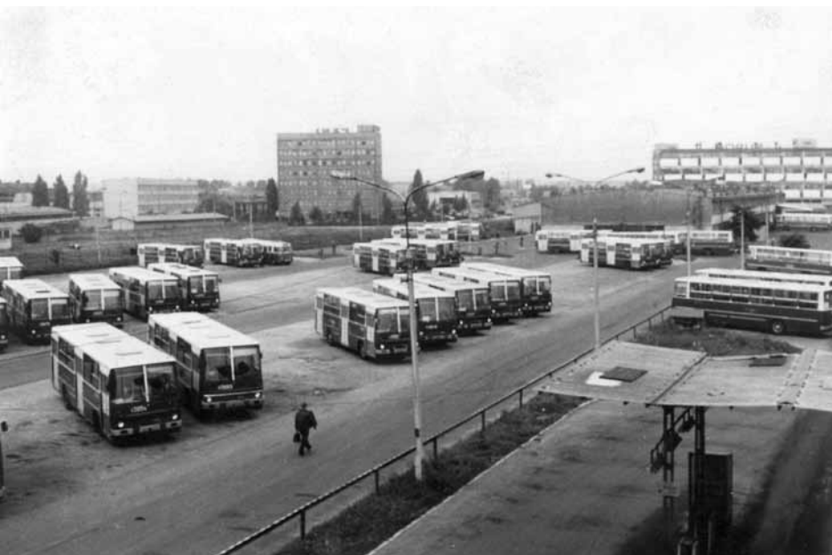
Zajezdnia Płaszów – widok na plac postojowy
