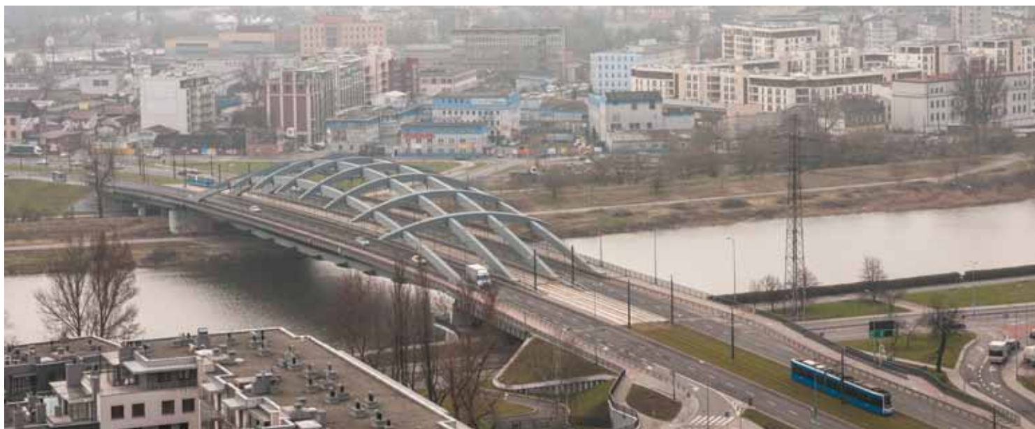
Widok na Most Kotlarski i linię tramwajową
