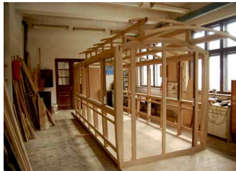
Złożona w całość konstrukcja pudła wagonu na terenie zakładu stolarskiego
