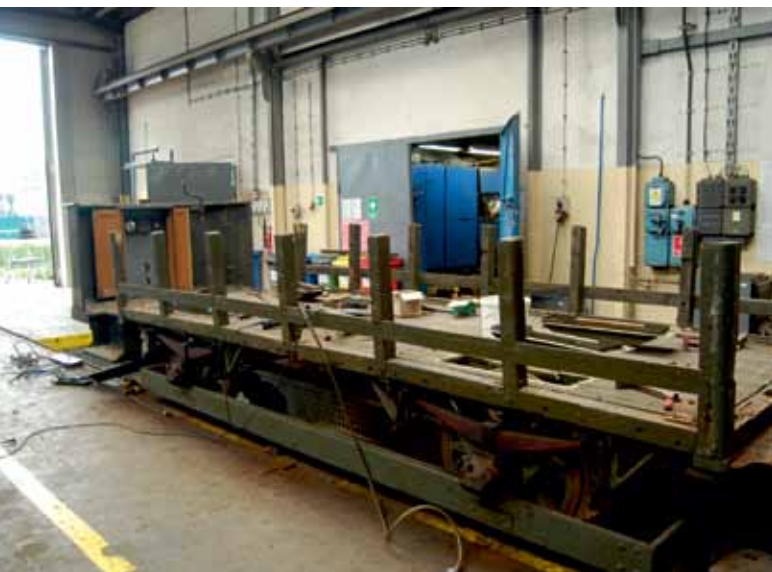
Początek prac rozbiórkowych na terenie zajezdni Nowa Huta.
