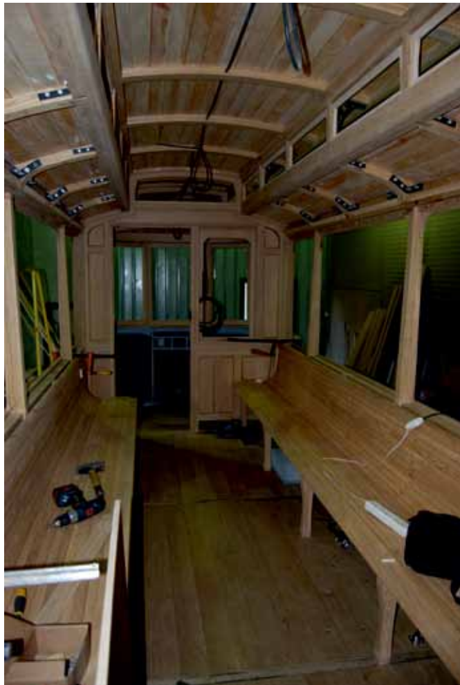
Ostatnie pasowanie elementów drewnianych wyposażenia wnętrza
