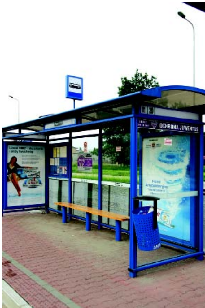
Przystanki przy ul. Lipskiej są często dewastowane
