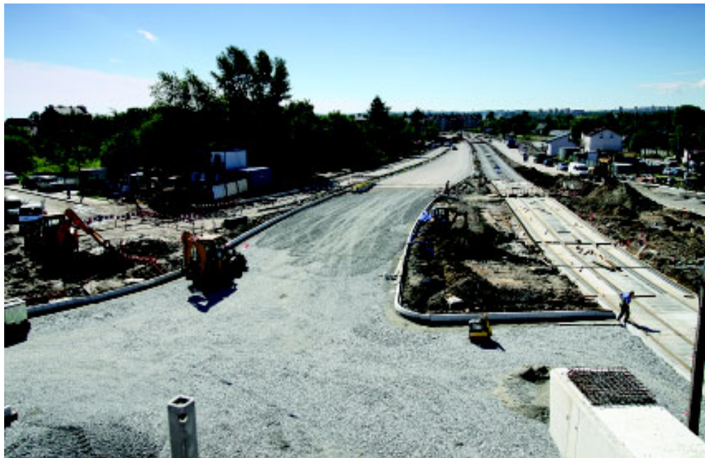
Ul. Kuklińskiego – widok z budowanej estakady
