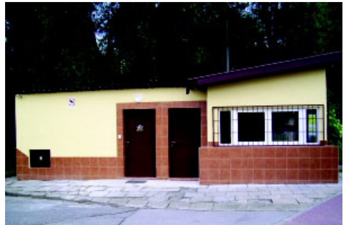
... i po remoncie
