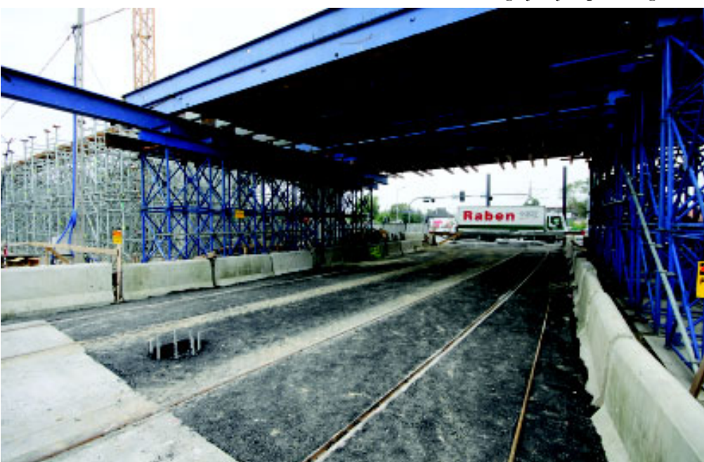
Gotowe torowisko pod budowaną estakadą
