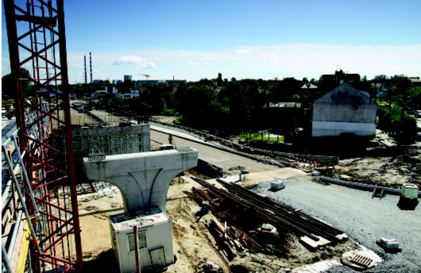
Konstrukcja estakady – widok od strony budowanej ul. Kuklińskiego
