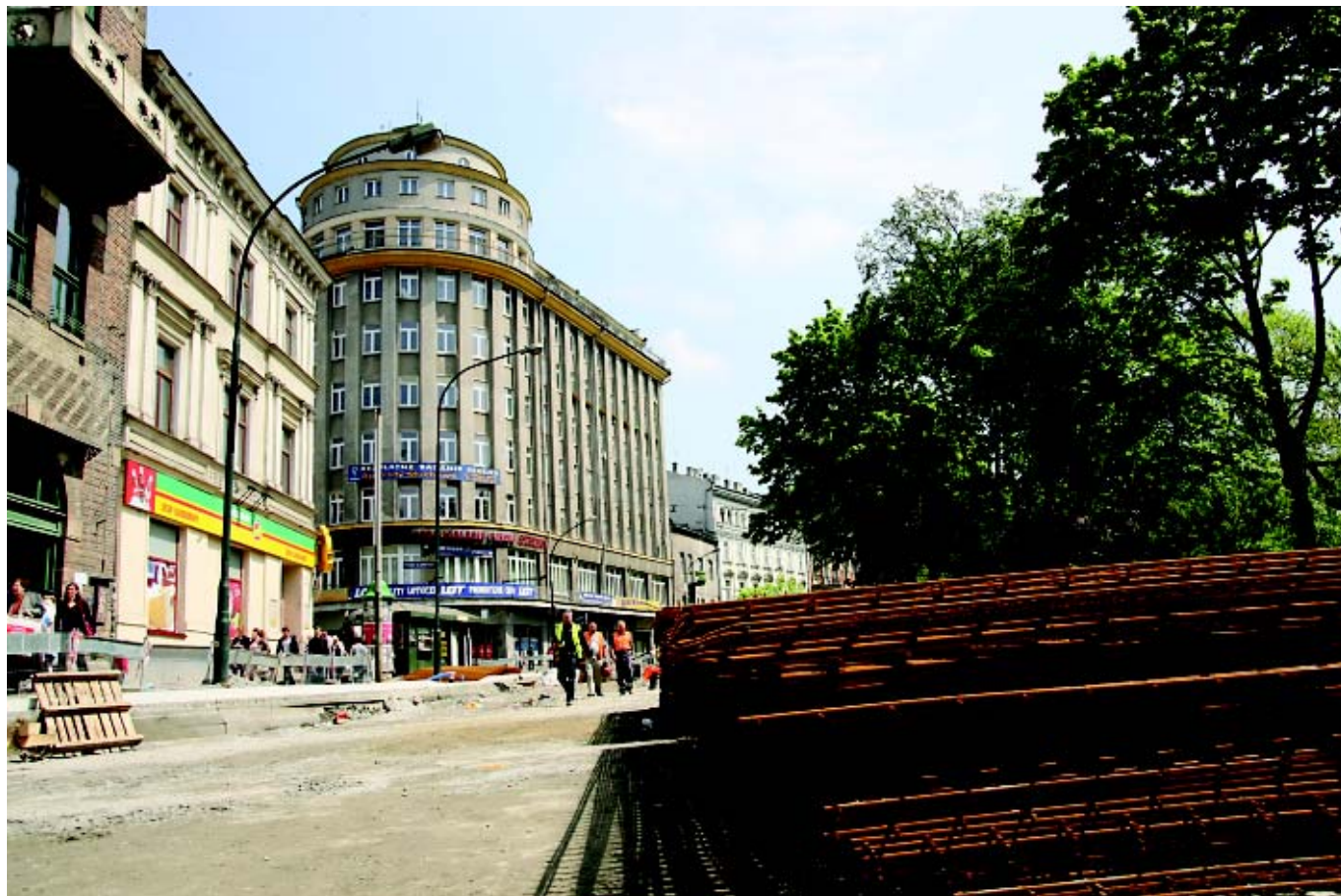
Priorytetem całej inwestycji jest jak najszybsze zakończenie prac na skrzyżowaniu ul. Długiej i Basztowej
