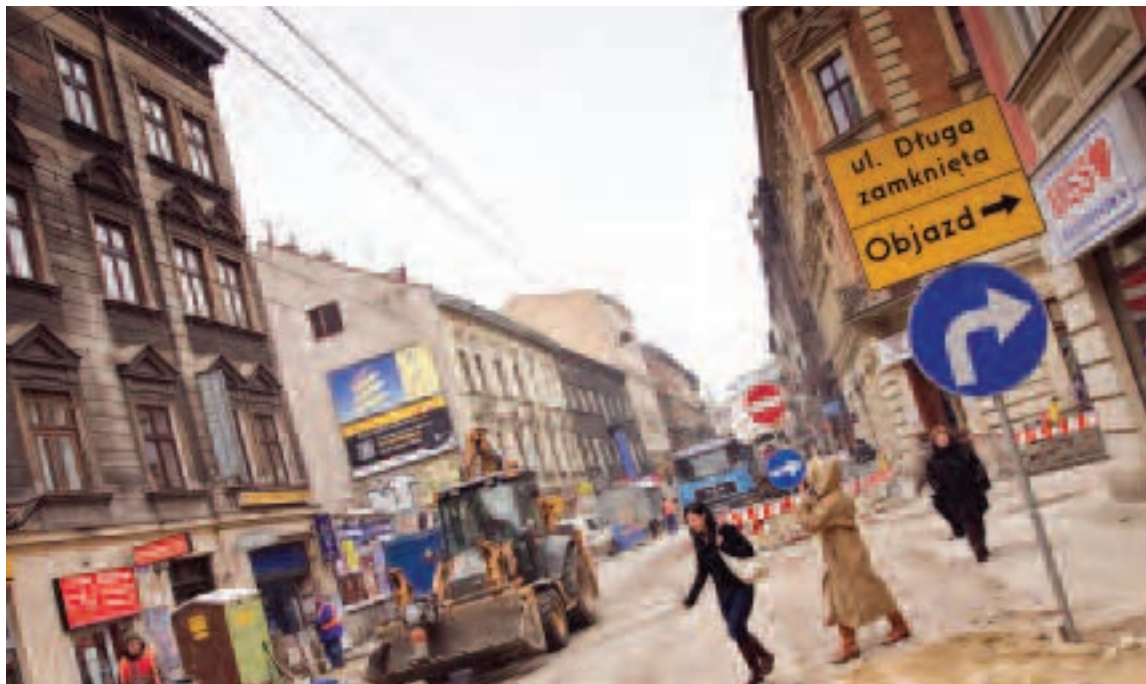
Na ul. Długiej od 1 marca trwa wymiana podziemnych mediów
