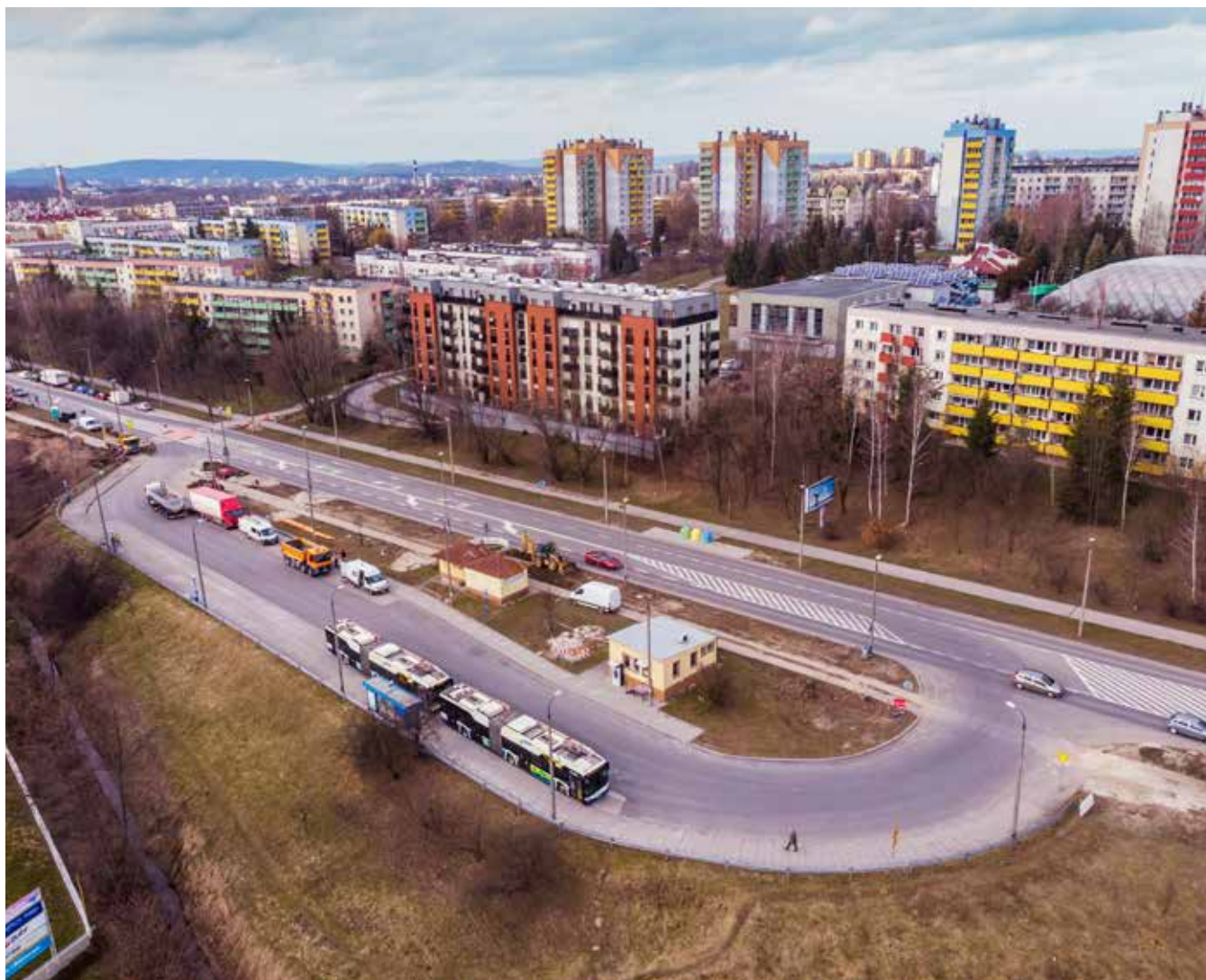
Pętla autobusowa przy ul. Stojalowskiego
